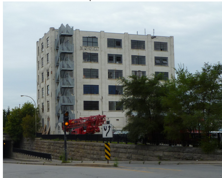
Ancien bâtiment industriel situé près de la rue Ontario
