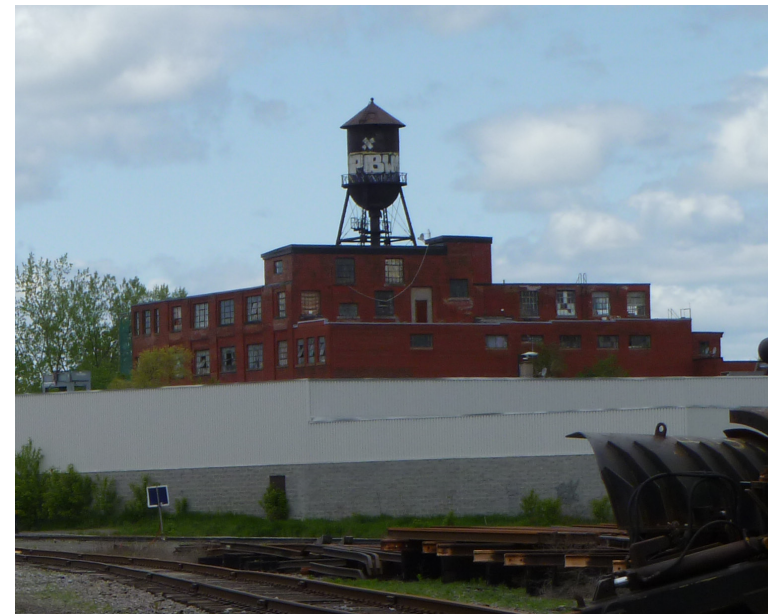
Château d'eau situé sur un ancien bâtiment industriel
