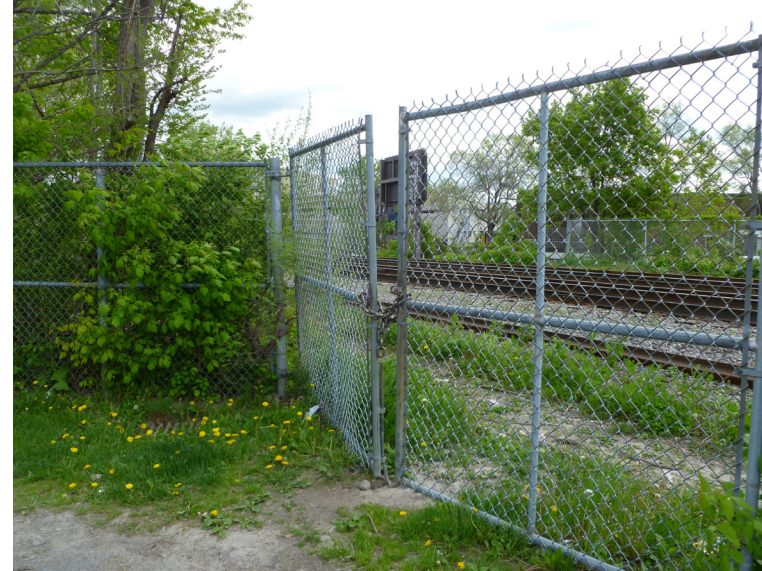
Porte d'entrée permettant d'accéder à la voie ferrée
