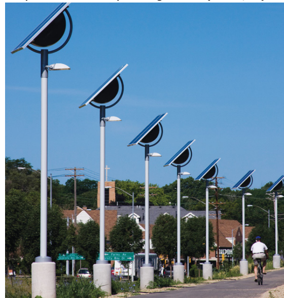
Lampadaires alimentés par énergie solaire (vue de jour)
