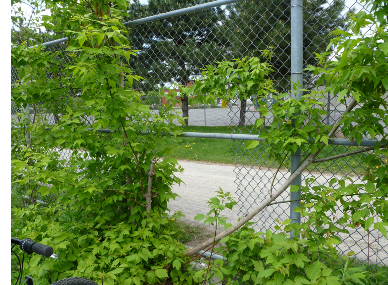
Clôture trouée aux abords de la voie ferrée
