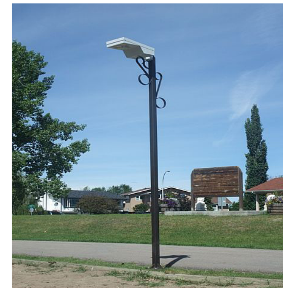
Lampadaire alimenté par énergie solaire et équipé d'un détecteur de mouvements
