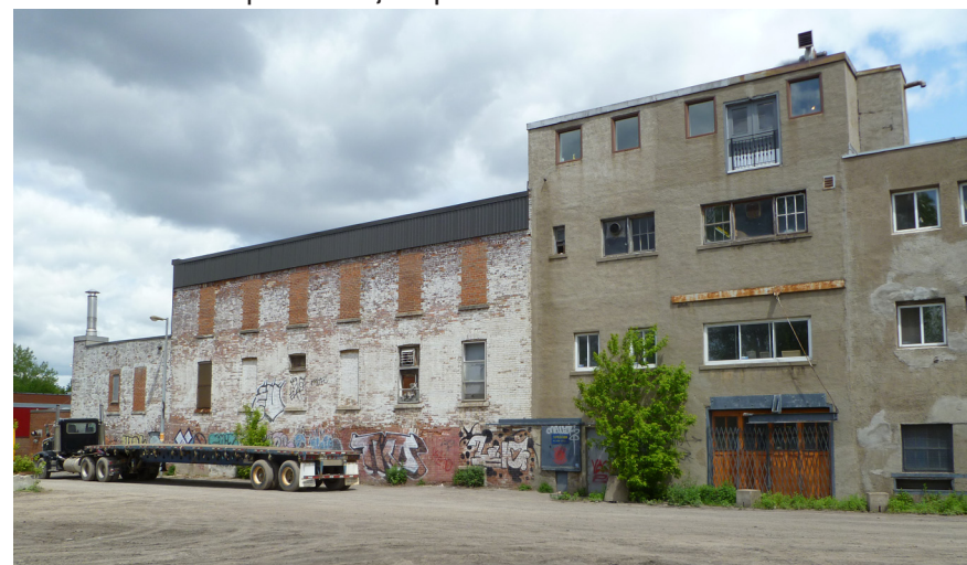
Efflorescence de la brique sur la majeure partie d'un bâtiment commercial
