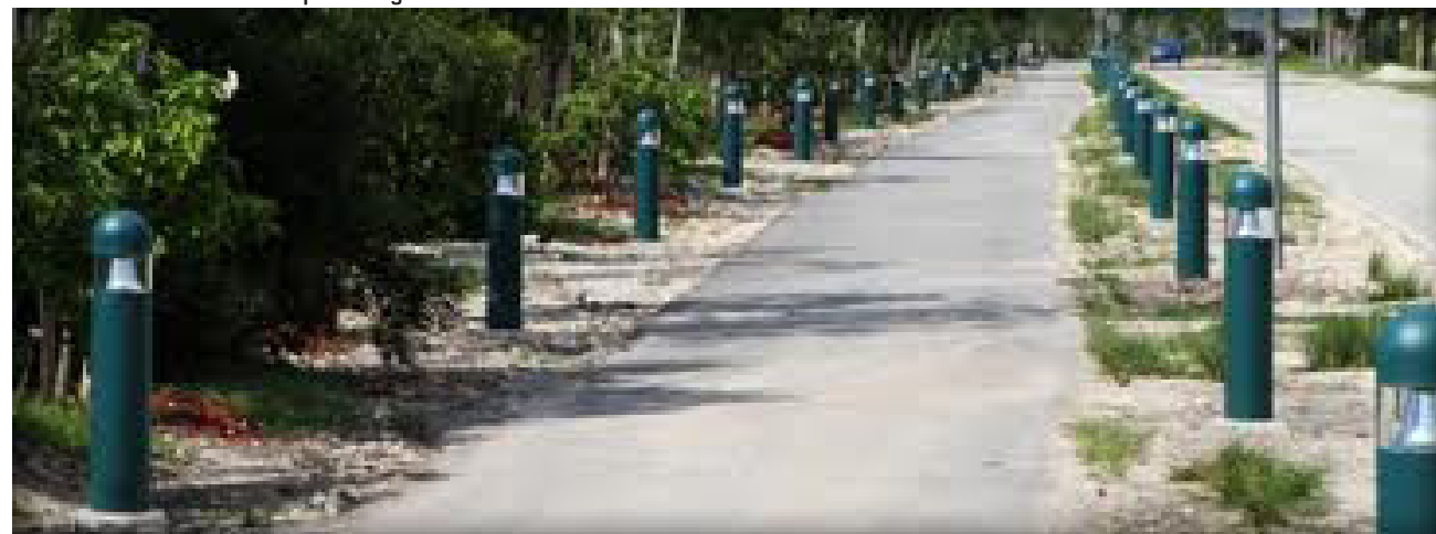
Bollards lumineux alimentés par énergie solaire
