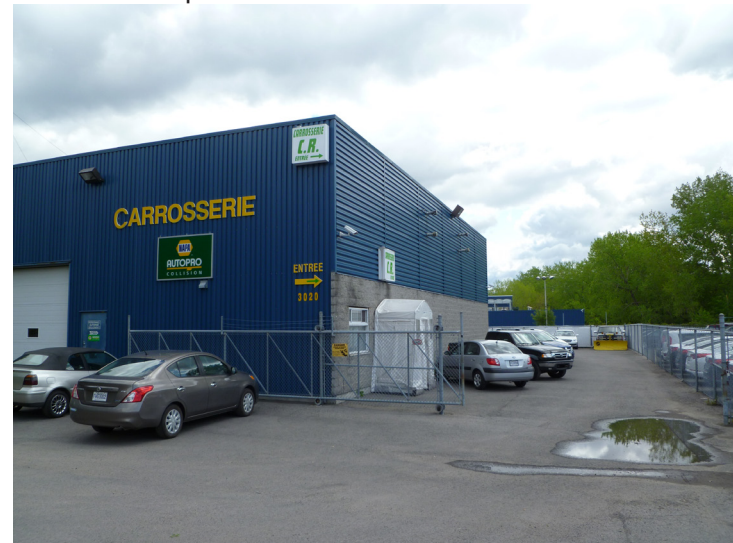
Commerce situé à proximité de la voie ferrée
